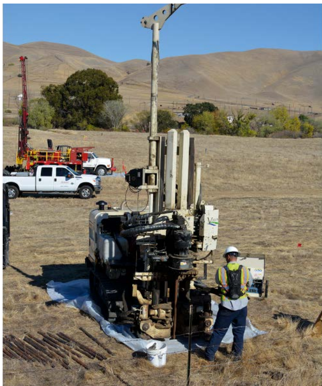
Abbildung 4: Direct-Push-Sondierung mit Injektionsspitze
